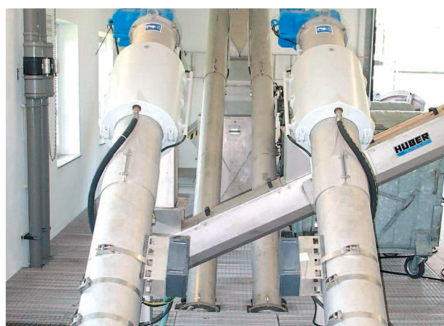
ROTAMAT® 一体化装置 Ro 5，地下安装，—用—备
