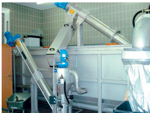
分砂螺杆之后安装 HUBER 洗砂装置 RoSF 4/t
