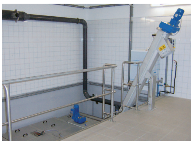
ROTAMAT® 一体化装置Ro 5，尾端内置式洗砂功能
