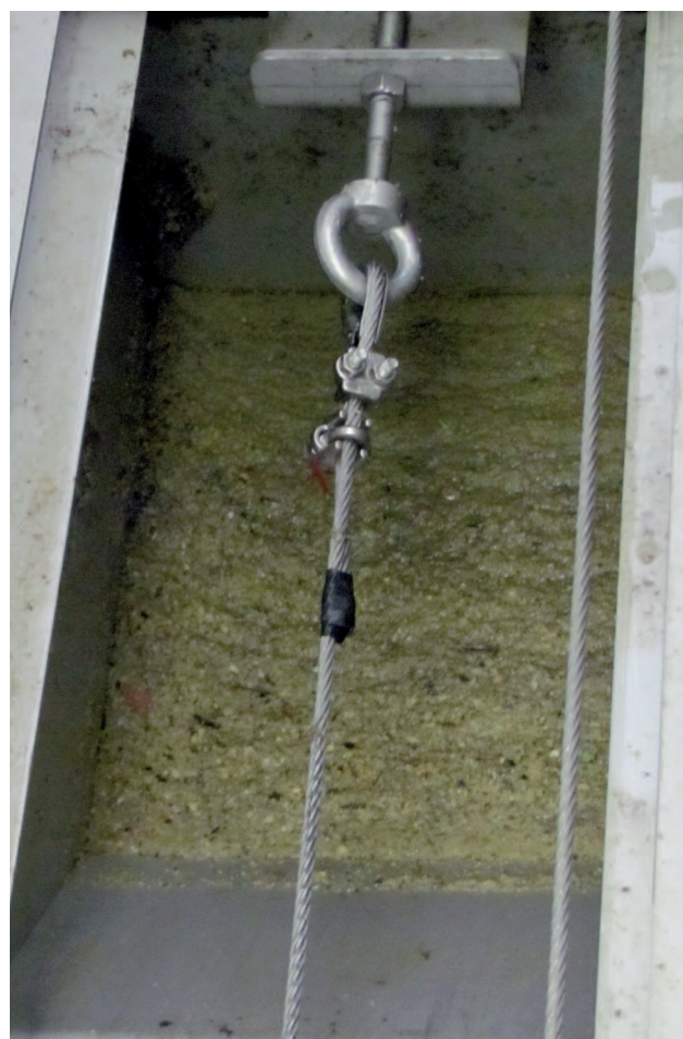
油脂刮板是根据纵向刮板器原理工作, 可将漂浮油脂推入泵井。
