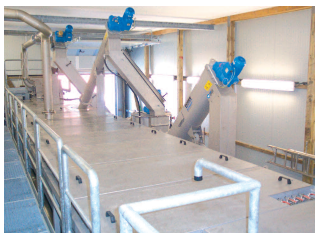
ROTAMAT® 一体化装置 Ro 5 卫生排渣和排砂
