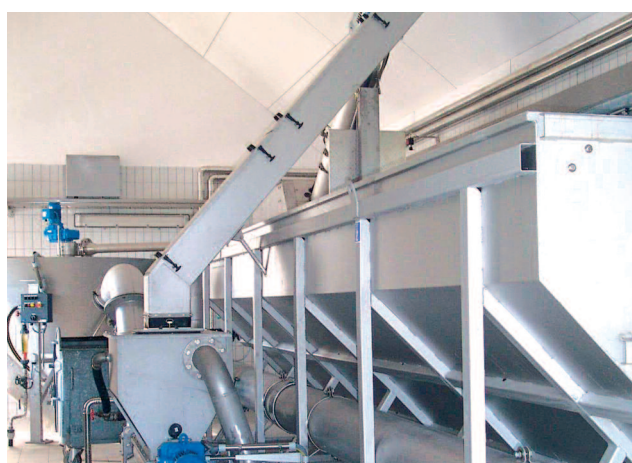
ROTAMAT® 一体化装置Ro 5 后续配置栅渣强力洗滌压榨机 WAP/SL
